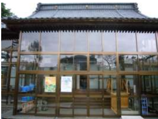
風除室に覆われた本堂の外観
