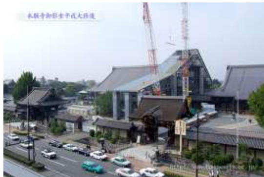
西本願寺御影堂 素屋根解体工事
